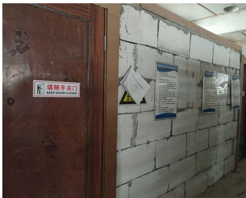
危险废物贮存间
