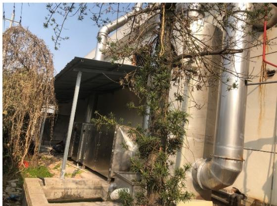
水喷淋+油雾过滤棉+UV 光解处理设施
