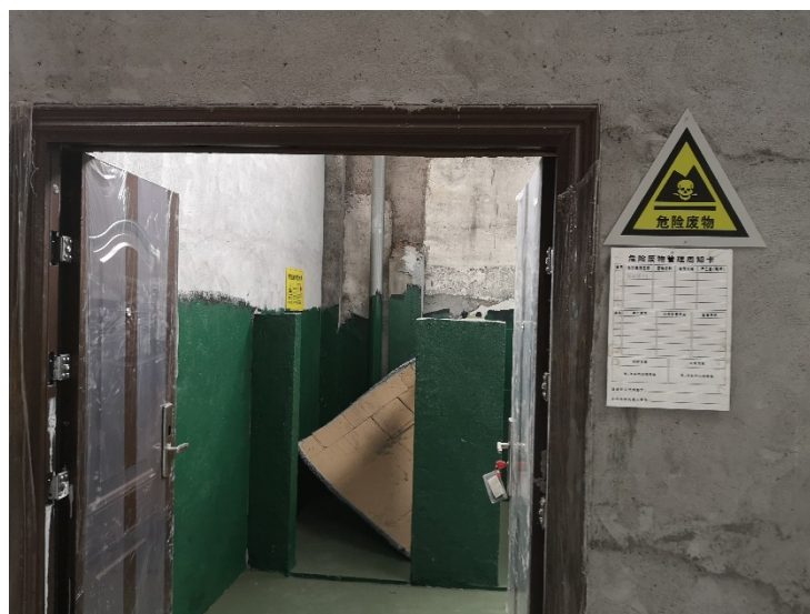
危险废物贮存间
